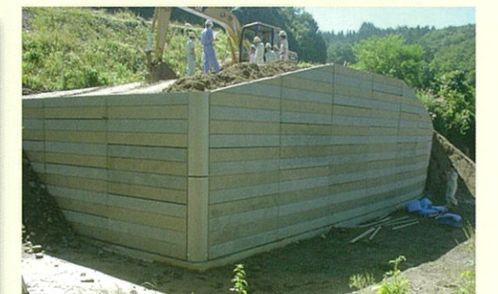
【試験施工状況】
