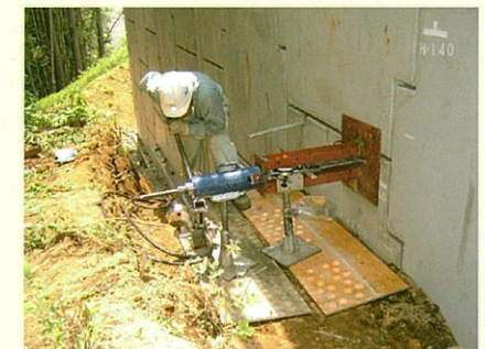
【幅広ストリップの引抜き試験状況】
