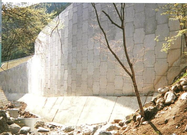
コンクリート架台を護岸として併用した例
