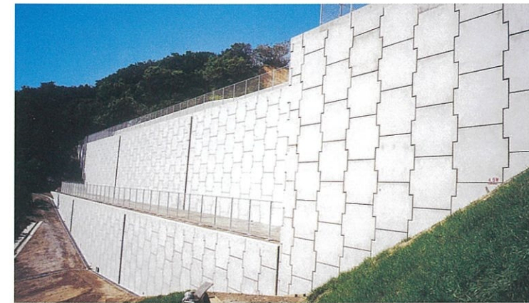
▲二段テールアルメ (造成)
