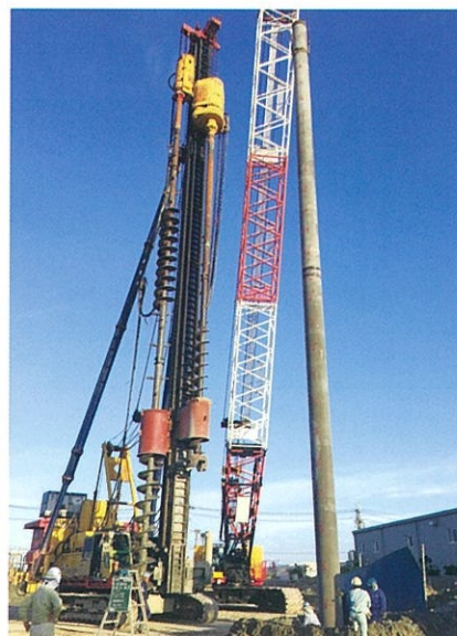
▲Hyper-ストレート工法施工例
