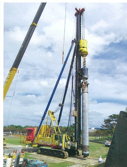
▲中掘工法施工例
